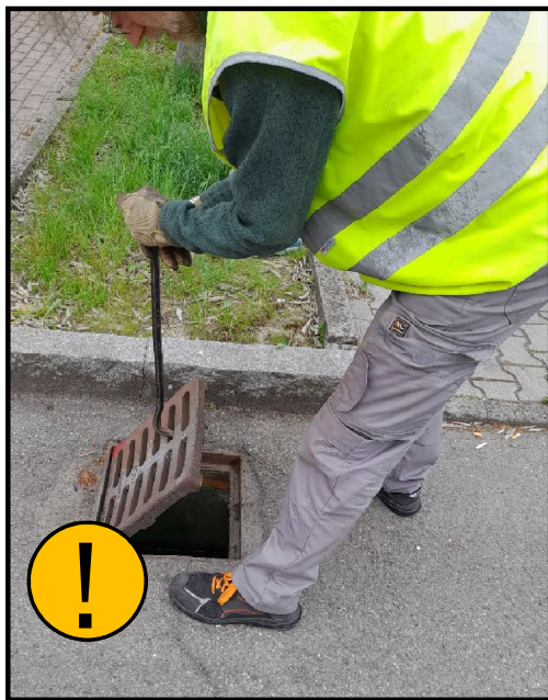
Apertura e messa in sicurezza del tombino
